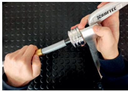
3. Виконати розкалібрування труби за допомогою ручного або акумуляторного розширювача:
